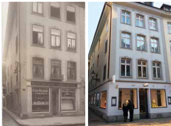
Die Fassade der Goldschmiede gestern (etwa 30er Jahre) und heute.
